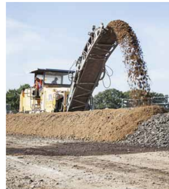
Fräsen des Fahrbahnumbaus der Richtungsfahrbahn Nord erfolgt auf rund 30 Kilometern.
