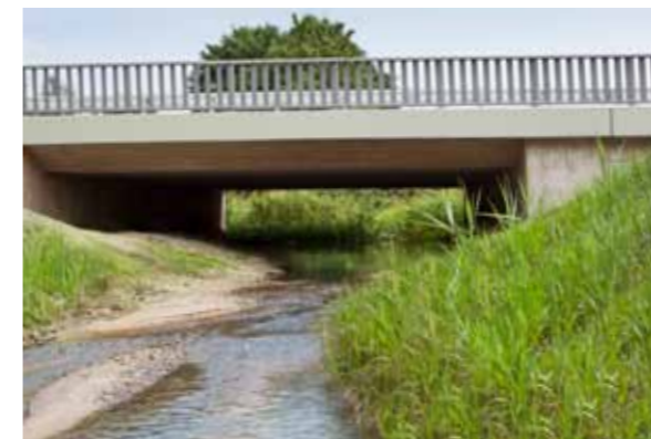
Kleintierdurchlässe und Amphibienleitsysteme gewährleisten, dass auch kleinere Tiere unterhalb der Autobahn sicher auf die andere Seite gelangen.
