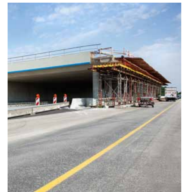
Mit 58 Metern Länge und 62 Metern Breite werden die Grünbrücken Wildtieren einen sicheren Weg über die A 7 bieten.
