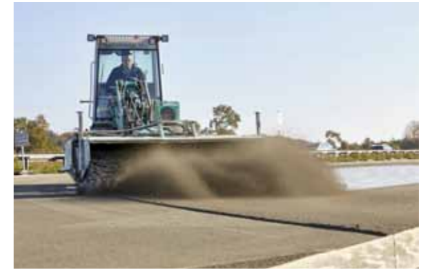
Die Betonfahrbahn wird an der Oberfläche ausgebürstet. Dadurch kommen hochwertige Gesteinskörnungen zum Vorschein, die eine dauerhafte Griffigkeit garantieren.
