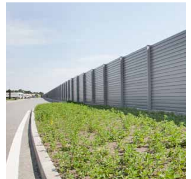
Hochabsorbierende Lärmschutzwände sind platzsparend und können insbesondere an schmalen Stellen eingesetzt werden.
