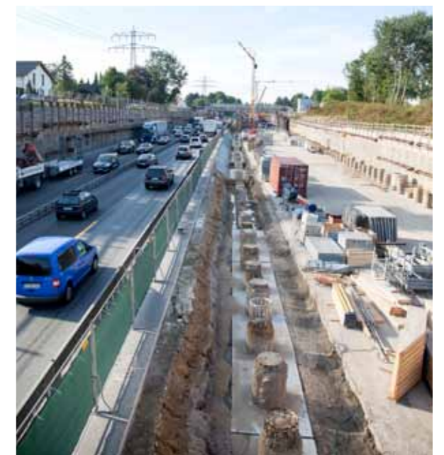
Vor Beginn des Baus der Tunnelwände und des Deckels wurde der Bereich verbreitert und die Seitenwände verankert.
