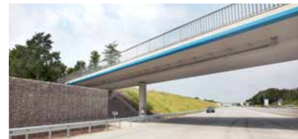
Brücken, die erhalten bleiben, werden halbseitig saniert – die andere Hälfte folgt nach dem Spurwechsel.
