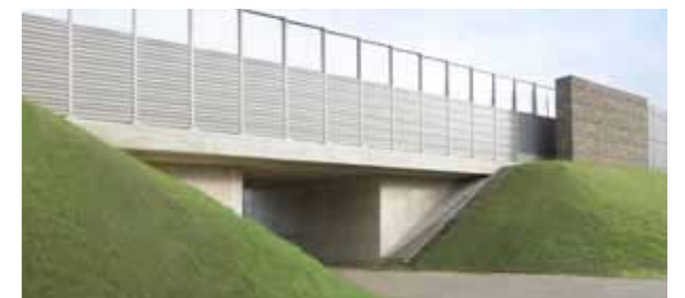
A-Bauwerke sind Brückenbauwerke entlang der Autobahn, d. h., auf ihnen verläuft die Autobahn über anderen Straßen, Bahngleisen oder Bachläufen.
