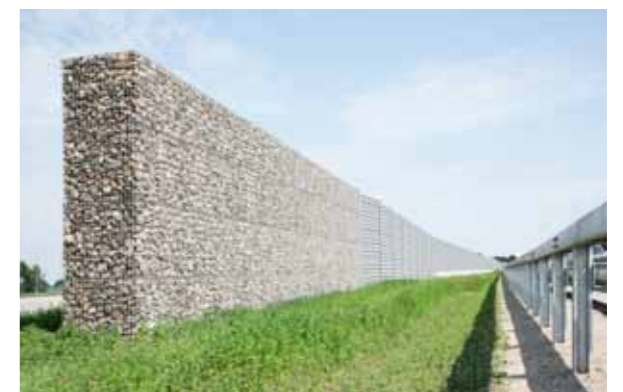
Gabionen – mit Steinen befüllte Gitterkörbe – schützen die Umgebung vor Lärm.
