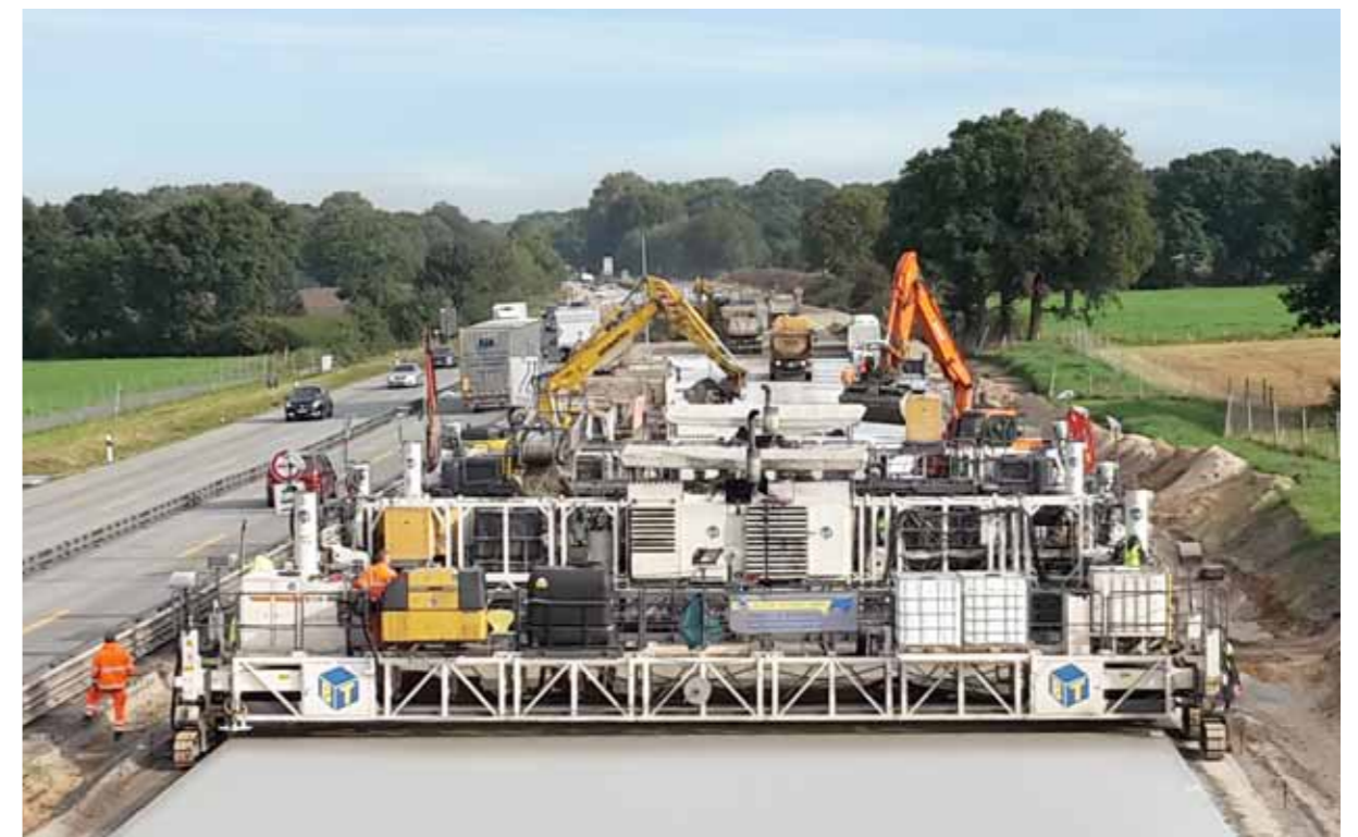
Herstellung der Betonfahrbahnen mit modernster Einbautechnik auf einer Breite von 14,5 Metern.
