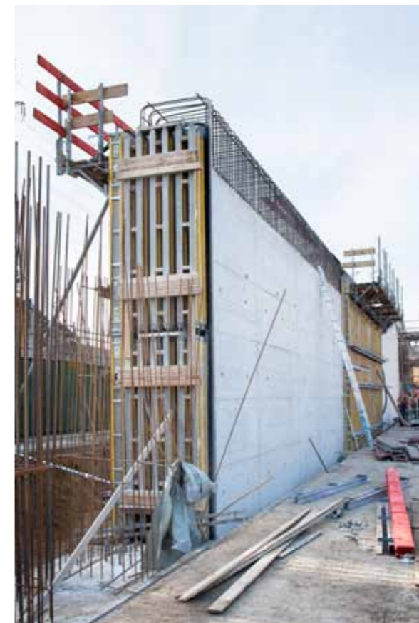
Wandelemente des Schnelsener Deckels nach der Betonage.
