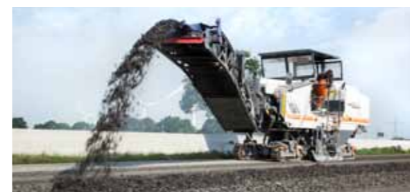
Alter Asphalt wird abgefräst und der Wiederverwertung zugeführt.
